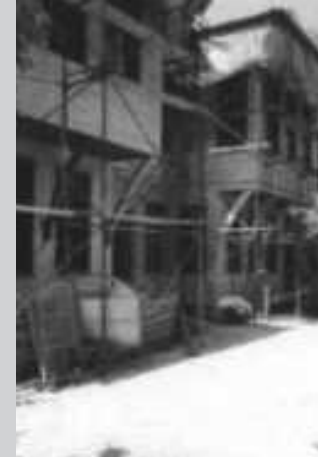
Sadullah Paşa Yalısı Onarım Projesi
